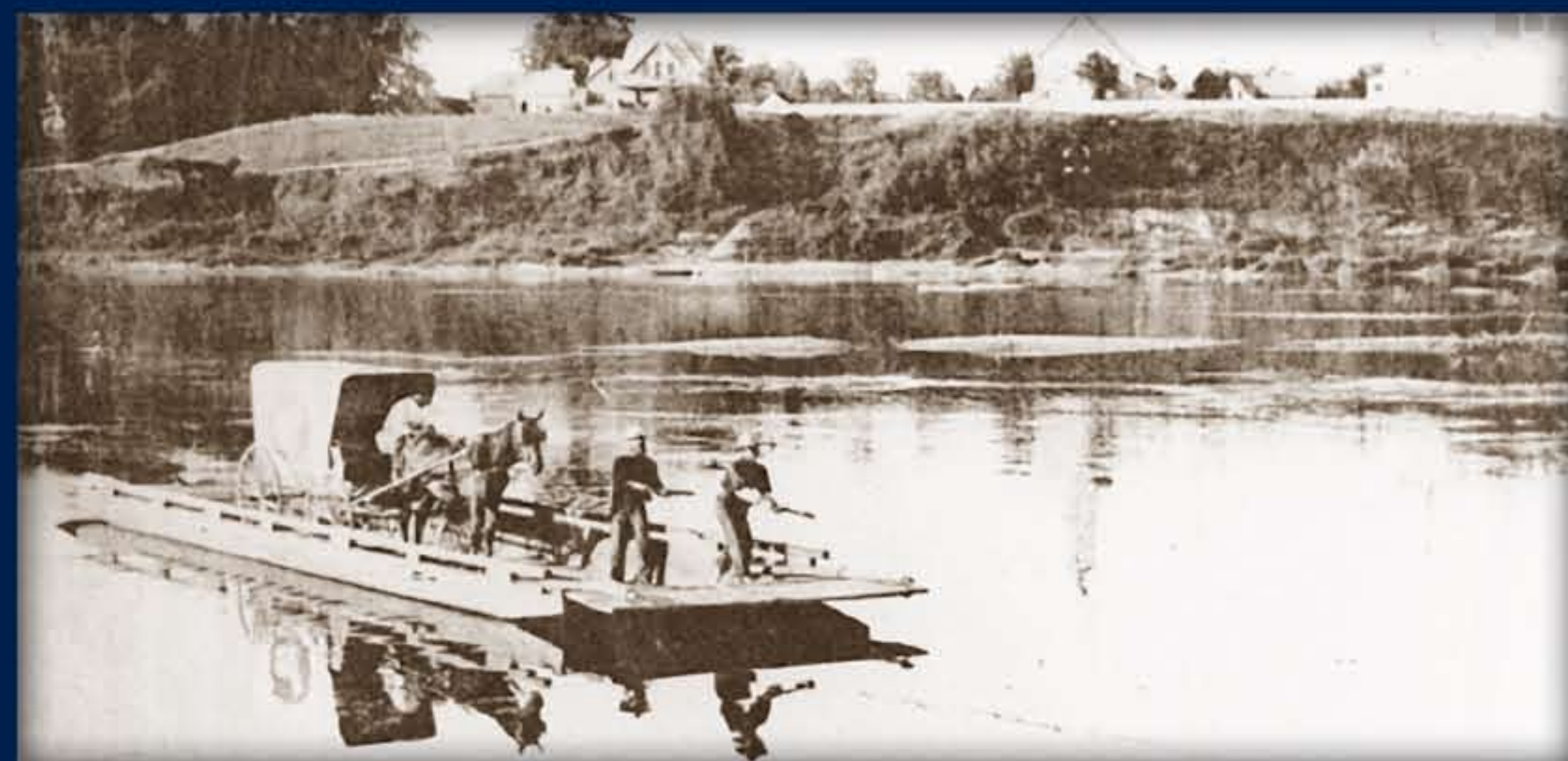
Bac pour traverser la rivière (avant 1906)
